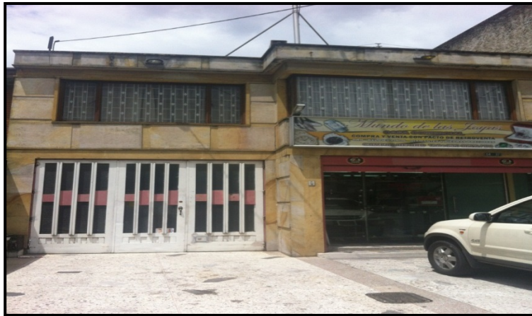
Fotografía No. 1y 2: Fachada y Aviso del establecimiento de comercio MUNDO DE LAS JOYAS ubicado en la Avenida Calle 68 No. 64-37.
